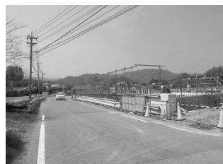
塩見大池線道路改良事業
