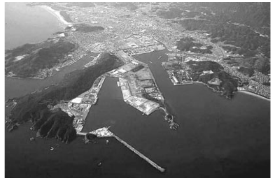
細島港17号岸壁
