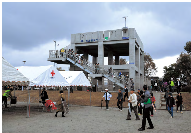
(左) 財光寺北市営住宅避難階段 (右上) 長江避難タワー (財光寺) (右下) 堀一方避難タワー (日知屋)
