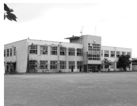
▲昭和31年建築の細島小学校
