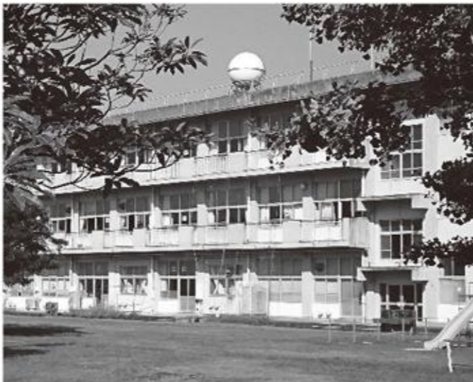
▲冷房設備のない市内小中学校
