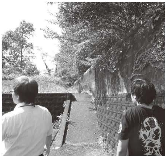
▲撤去・改修が予定の、ひむかひこばえ学園のブロック塀
