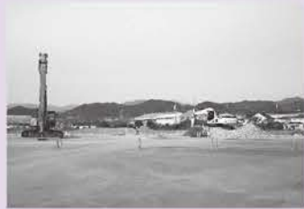
▲更地工事が進む工場跡地
