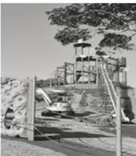
▲ 遊具施設の設置工事が進むサンパーク公園
