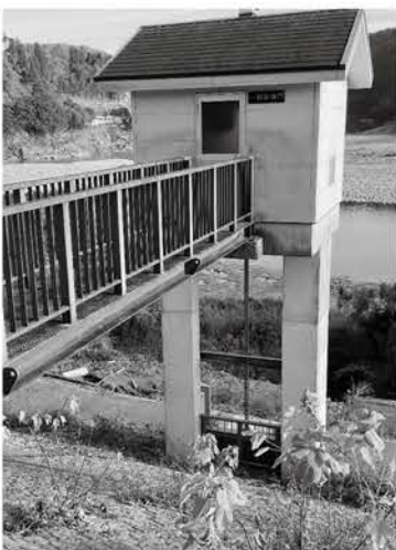
▲ 遠隔操作が望まれる小野田樋門
